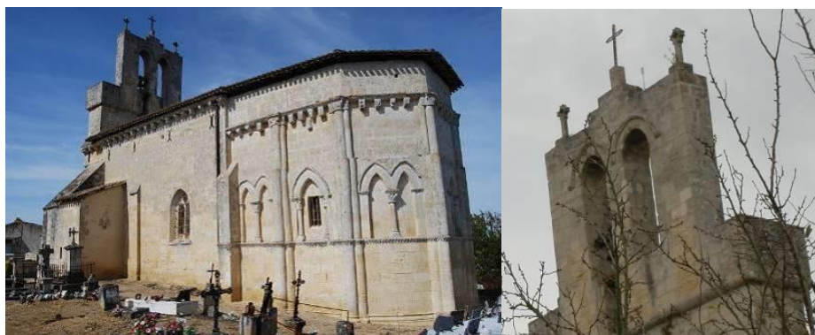
Figure 17: l'église Saint-Saturnin à Camarsac
